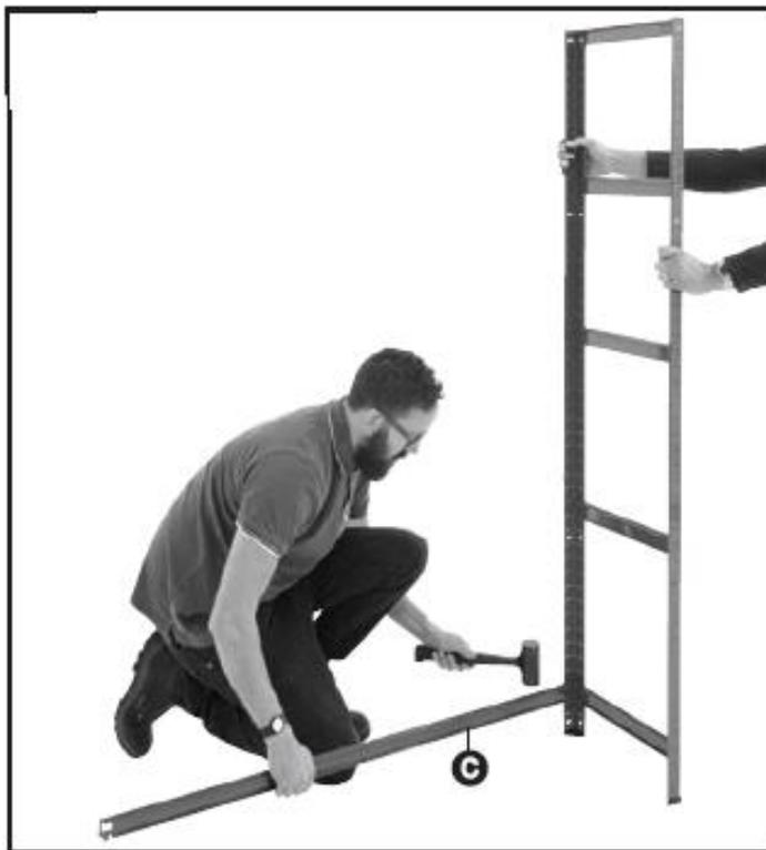
**8^ PASSAGGIO:** Montare l'altra estremità della traversa (C) nel secondo telaio laterale, alla stessa altezza.
